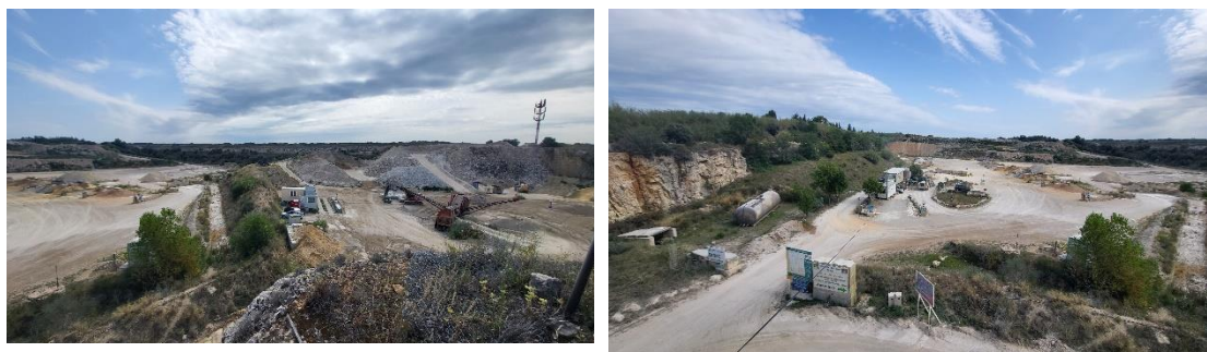
Site d'enfouissement et de recyclage de matériaux inertes dans l'ancienne carrière de Roques Haute. Source : Verdi, 2023
