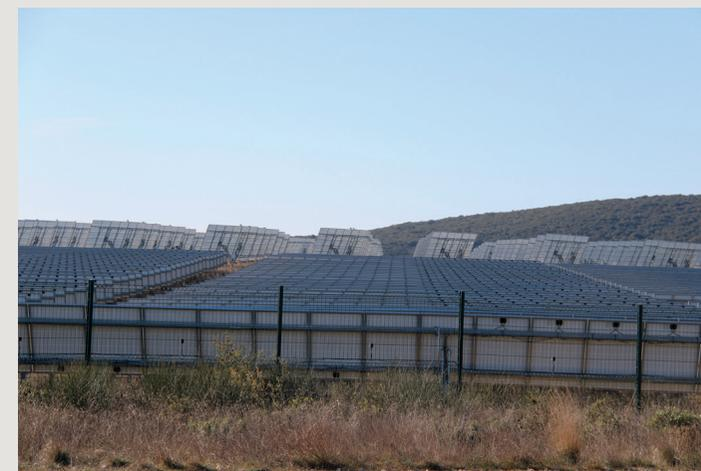
▲ Le parc photovoltaïque d'Aigaliers sur le plateau boisé de la Chau, intégrant deux technologies photovoltaïques : panneaux sur trackers 1 axe et modules à concentration sur trackers 2 axes. A sa création en 2016, il est le plus important parc solaire à concentration en France
